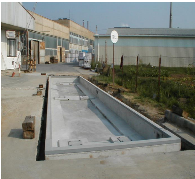
obr. 3. prefabrikovaná vana úrovně SMV
